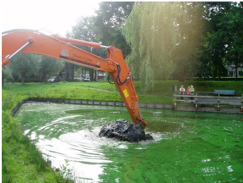
Figuur 38: Baggeren in Heesch
