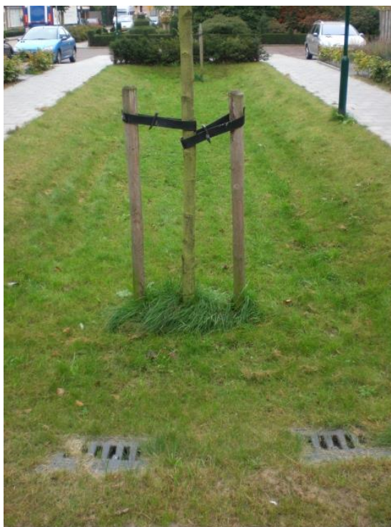
Figuur 28 voorbeeld van een 'strak' vormgegeven wadi met slok-op's en drain, Pastoor Hackenstraat in Sint-Oedenrode.
