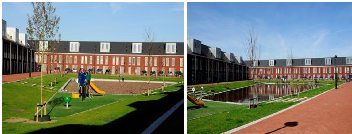
Figuur 30: waterplein Eikendonk ('s-Hertogenbosch) tijdens droog weer en tijdens test met vulling plein
